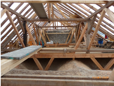
Zimmermannsmäßige Instandsetzung der hölzernen Dachkonstruktion. Die durch Pilz- und Insektenbefall sowie durch Feuchtigkeit geschädigten Balken sind unter größtmöglichem Erhalt der noch gesunden Bereiche zurückgeschnitten und mit passgenau eingefügten Nadelholz-Farbkernhölzern ergänzt worden. Betroffen waren insbesondere Teilstellen an den Traufen und der Krüppelwalm. An den Traufen sind partiell additive Sparreergänzungen vorgenommen worden, um die Bestandshölzer erhalten zu können.
