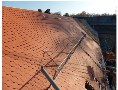
Lieferung und Einbau neuer Schalungen / Lattungen. Neueindeckung des Ostflügels mit Biberschwanzziegeln. Kleinere Bereiche (Zwickel zwischen Krüppelwalm und Treppenturmstumpf) sind mit Schiefer und Bleiblech abgedeckt worden. Erneuerung der Dachrinnen und Fallrohre.
