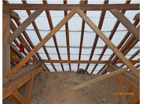
Zimmermannsmäßige Instandsetzung der hölzernen Dachkonstruktion. Die durch Pilz- und Insektenbefall sowie durch Feuchtigkeit geschädigten Balken sind unter größtmöglichem Erhalt der noch gesunden Bereiche zurückgeschnitten und mit passgenau eingefügten Nadelholz-Farbkernhölzern ergänzt worden. Betroffen waren insbesondere Teilstellen an den Traufen und der Krüppelwalm. An den Traufen sind partiell additive Sparreergänzungen vorgenommen worden, um die Bestandshölzer erhalten zu können.
