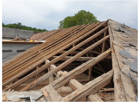
Abbruch / Rückbau und Entsorgung der vorh. verschlissenen Biberschwanzziegel-Dacheindeckung und der Schalung / Lattungen
