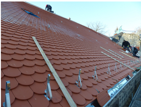
Lieferung und Einbau neuer Schalungen / Lattungen. Neueindeckung des Ostflügels mit Biberschwanzziegeln. Kleinere Bereiche (Zwickel zwischen Krüppelwalm und Treppenturmstumpf) sind mit Schiefer und Bleiblech abgedeckt worden. Erneuerung der Dachrinnen und Fallrohre.
