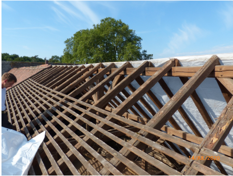
Abbruch / Rückbau und Entsorgung der vorh. verschlissenen Biberschwanzziegel-Dacheindeckung und der Schalung / Lattungen
